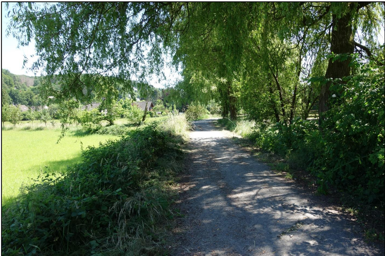
Abbildung 6: Vorhandener Hochwasserschutzdamm, abschnittsweise mit Gehölzen bewachsen
