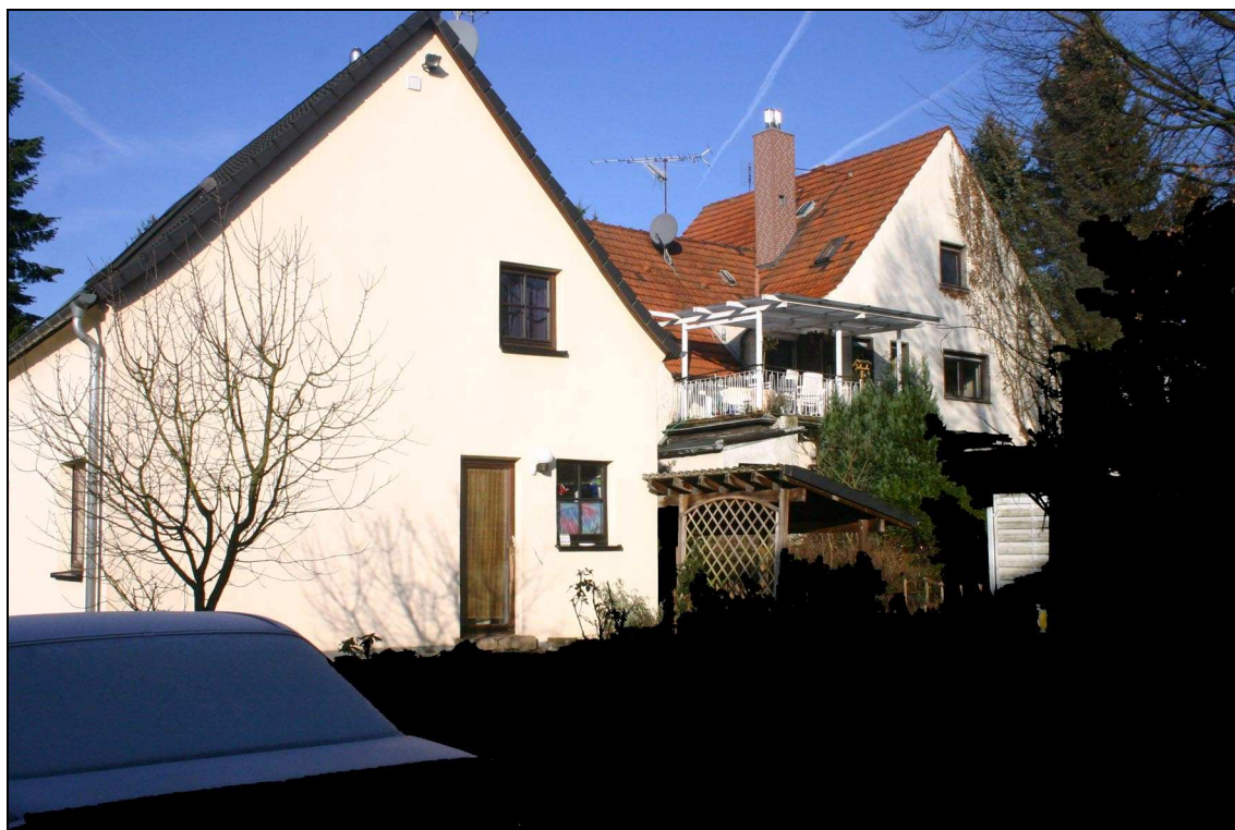
Foto 7: Südliches (links) und nördliches Wohnhaus von Südosten (Flöckberg)
