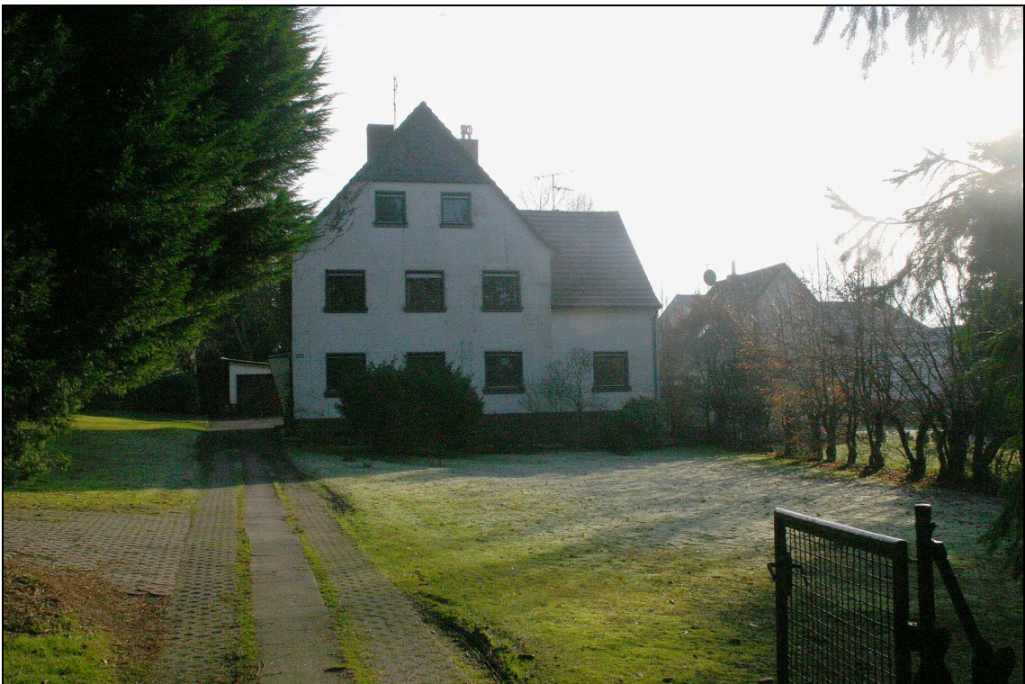
Foto 6: Nördliches Wohnhaus von Westen (Bensberger Straße)
