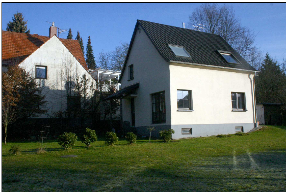
Foto 8: Südliches Wohnhaus von Südwesten
