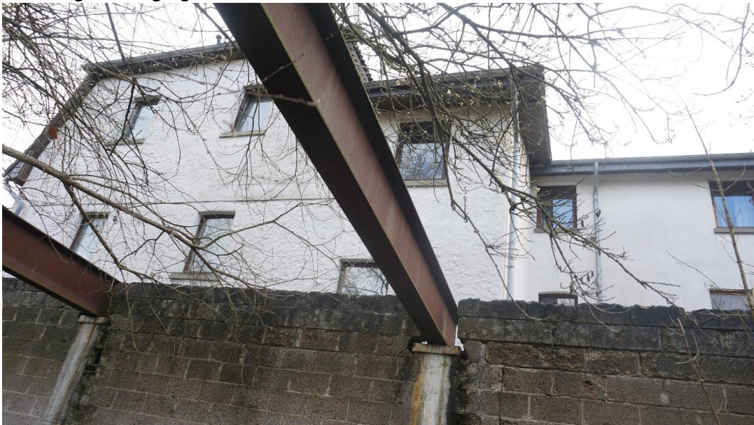
Abbildung 7: Wohn-/Geschäftshaus Nordwestseite, Wand der Werkstatt
