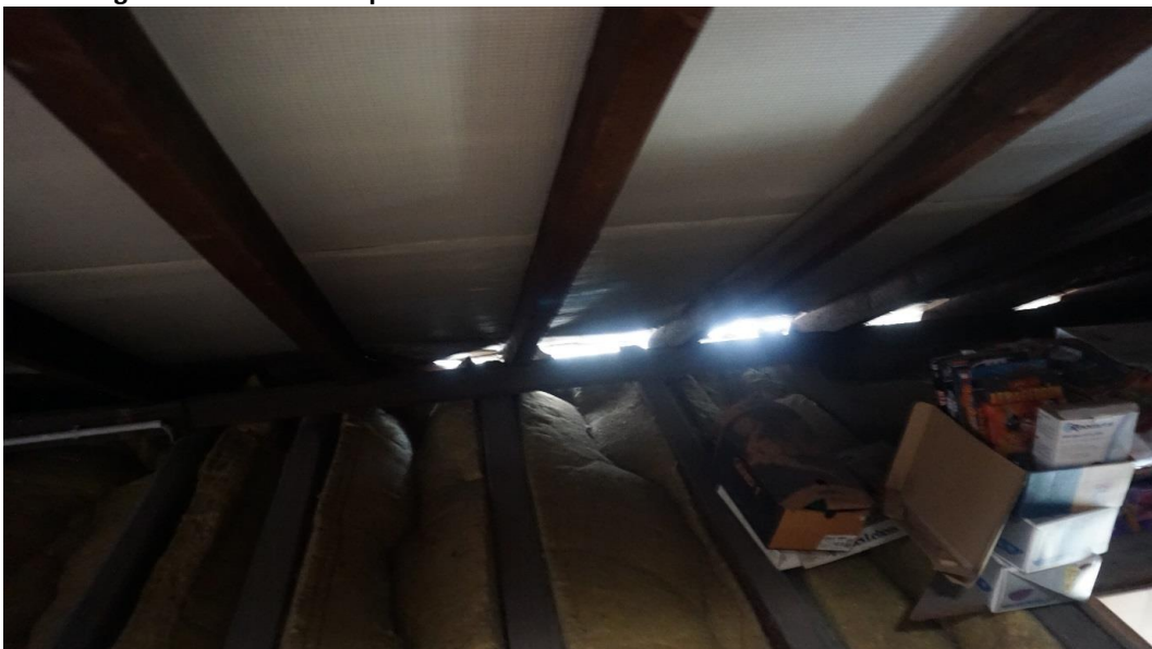
Abbildung 5: Dachboden, Öffnungen im Traufenbereich
