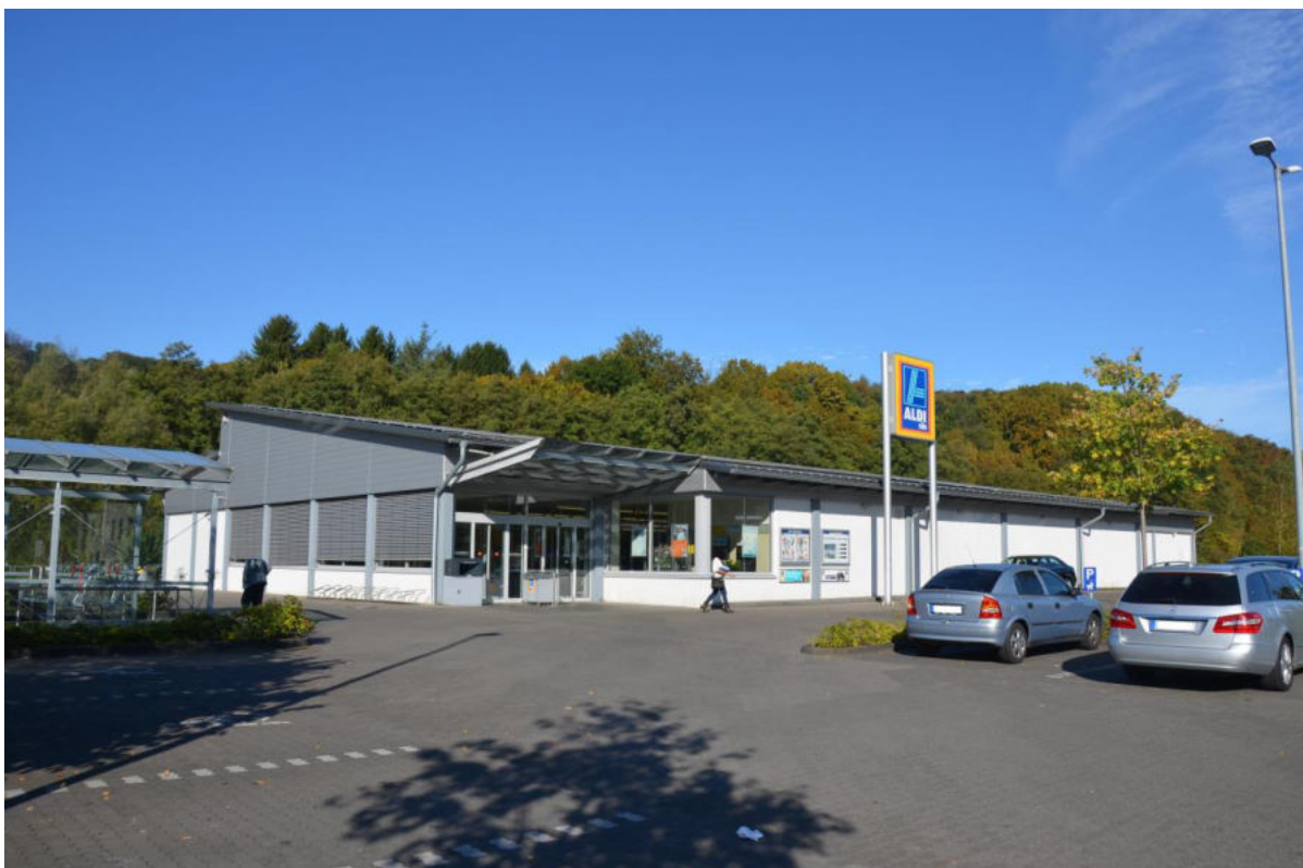
Nahversorgung Lehmbach, Aldi Hoffnungsthal
