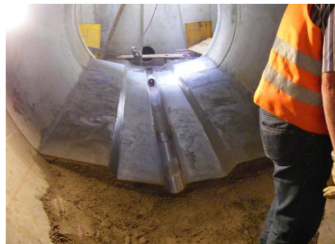
Abb.: Drosselbauwerk am SAS Gerhart-Hauptmann-Straße, Einbau der TW-Rinne
