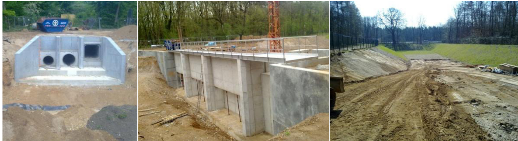
Abb.: Bau der RWBA Kleineichen – Einlauf-, Trennbauwerk, Versickerungsbecken
