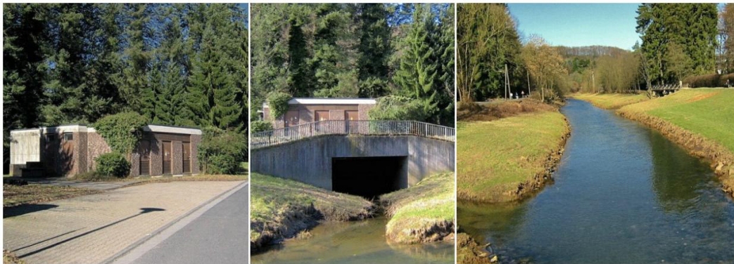
Abb.: RÜB Volberg, Einleitungsbauwerk, Sülz gegen Fließrichtung
