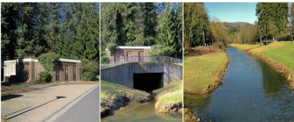
Abb.: RÜB Volberg, Einleitungsbauwerk, Sülz gegen Fließrichtung
