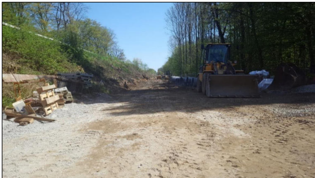
Abb.: RW-Verbindungssammler DN 800; neue Trasse parallel zum Bahndamm
