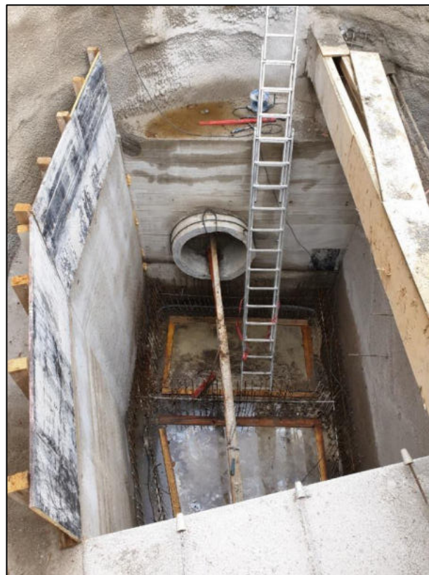
Abb.: Bau des Steuerbauwerks E 230a in Stümpfen
