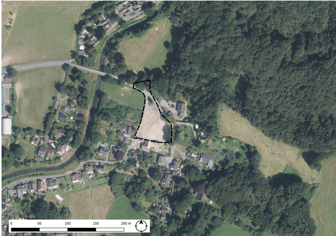
Abbildung 3 Luftbild des Geltungsbereiches sowie der umliegenden Strukturen aus 2018
